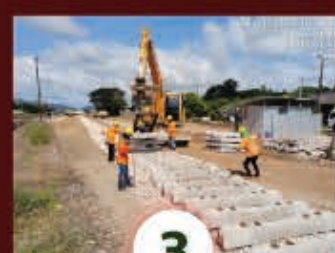
3 วางราง หมอนคอนกรีต
