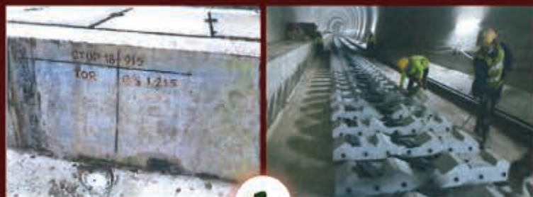
1 การเตรียมงานและการติดตั้งองค์ประกอบราง
