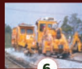
6 โรยหินรองรางชั้น 2-3 และอัดหินโรยทาง พร้อมปรับแนวและ ระดับของทางรถไฟ
