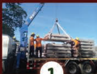
1 กระจาย หมอนคอนกรีต
