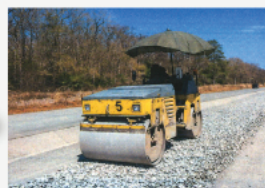
รถบดสำหรับบดอัดหินโรยทางชั้นแรก
