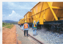
Ballast Hopper Wagon สำหรับโรยหินชั้นถัดไป
