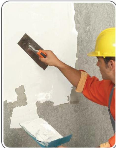
อะคริลิกสำเร็จรูป สำหรับงานฉาบบาง เพื่อปรับซ่อมผิวคอนกรีต รูพรุนตามเดิม ก่อนงานทาสี คุณลักษณะ TOA 102 D-Cote เป็นอะคริลิกชนิดพิเศษ สำเร็จรูป ใช้สำหรับงานฉาบบาง บนผนังอาคาร ฝ้า และเพดาน เพื่อซ่อมแซมแก้ไขรอยแตกร้าวขนาดเล็ก รอยแตกคลายงาน รูพรุนอากาศ รูพรุนตามเดิม ทำให้งานฉาบดูเรียบเนียน สามารถทาสีปิดผิวเม็ดทราย ทั้งพื้นผิวเก่าและใหม่ก่อนการทาสี
