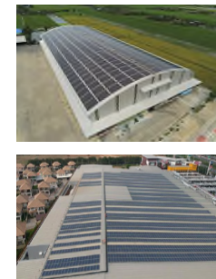
พลังงานแสงอาทิตย์ติดตั้ง
