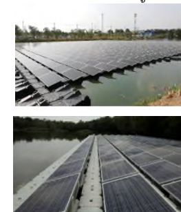
พลังงานแสงอาทิตย์ติดตั้ง
