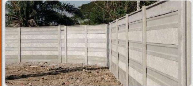
รั้วคอนกรีต
