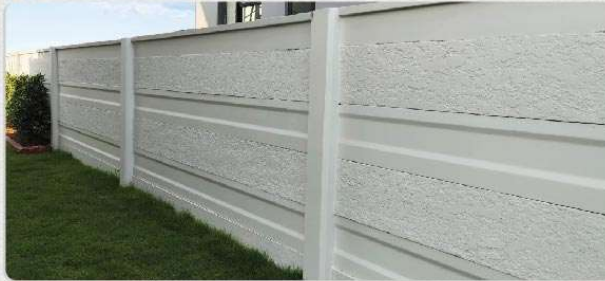
รั้วคอนกรีต
