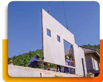
► ติดตั้งผนังสำเร็จรูป
