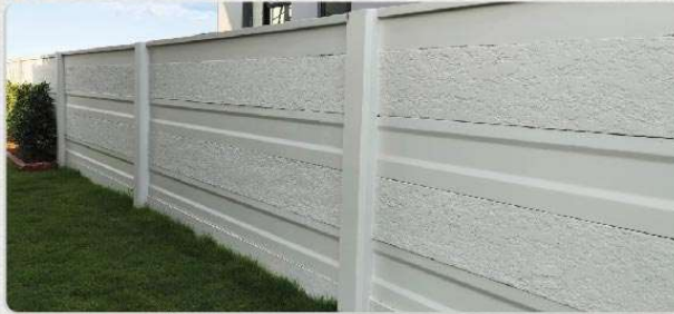
รั้วคอนกรีต
