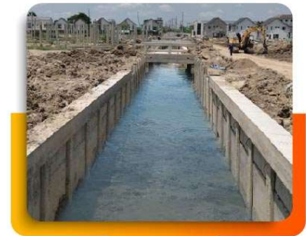
► ติดตั้งโครงสร้างคาน-เสาสำเร็จรูป
