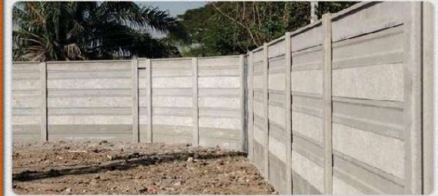
รั้วคอนกรีต
