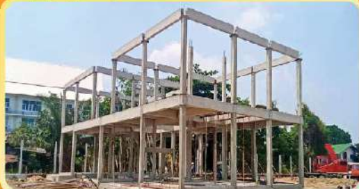
โครงสร้างคานเสา
