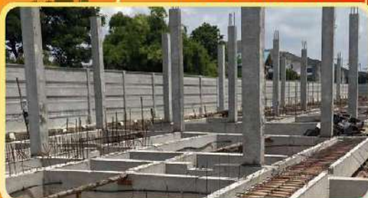
โครงสร้างคานเสา
