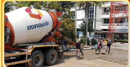
คอนกรีตผสมเสร็จ
