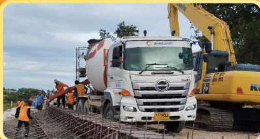
คอนกรีตผสมเสร็จ
