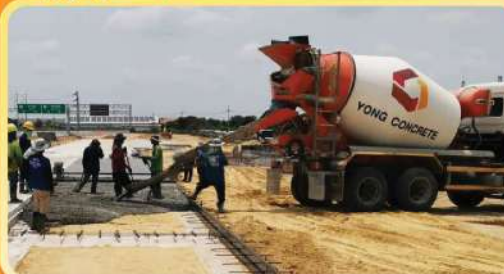
คอนกรีตผสมเสร็จ
