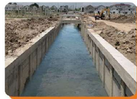
► ติดตั้งแผ่นกั้นดินคอนกรีต
