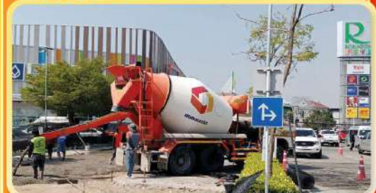
คอนกรีตผสมเสร็จ
