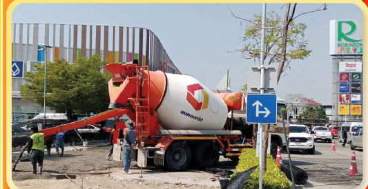
คอนกรีตผสมเสร็จ
