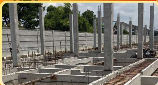
โครงสร้างคานเสา
