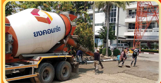
คอนกรีตผสมเสร็จ
