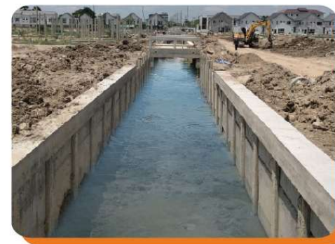
► ติดตั้งแผ่นกั้นดินคอนกรีต
