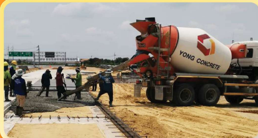
คอนกรีตผสมเสร็จ
