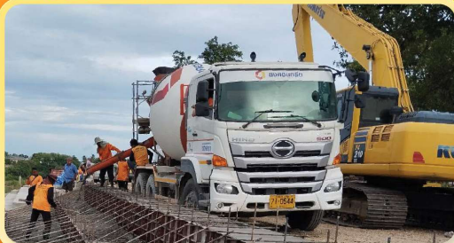
คอนกรีตผสมเสร็จ
