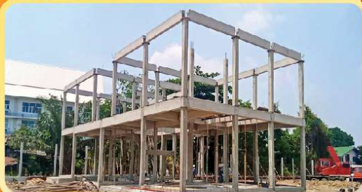
โครงสร้างคานเสา
