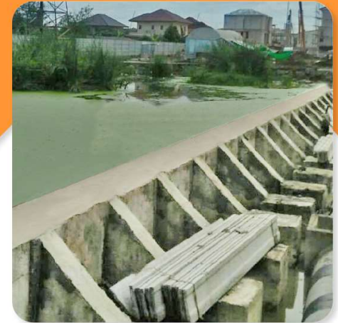
ติดตั้งแผ่นกันดินคอนกรีต
