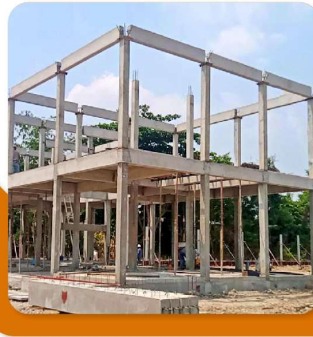
ติดตั้งโครงสร้างคาน-เสาสำเร็จรูป
