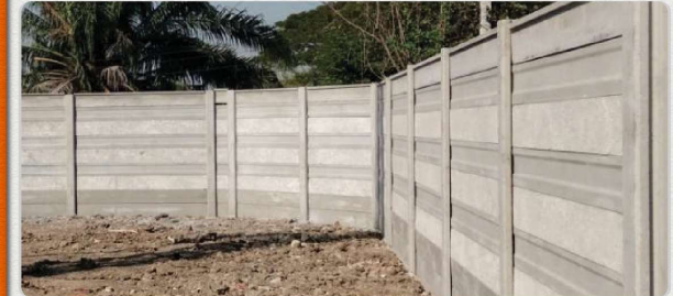
รั้วคอนกรีต
