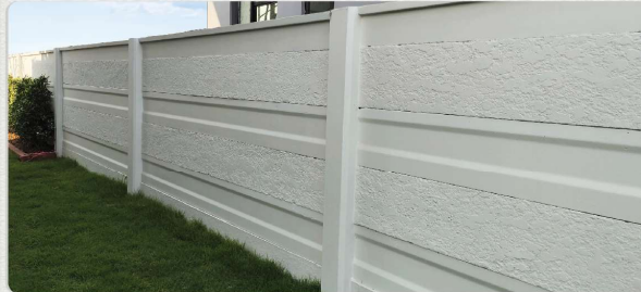
รั้วคอนกรีต
