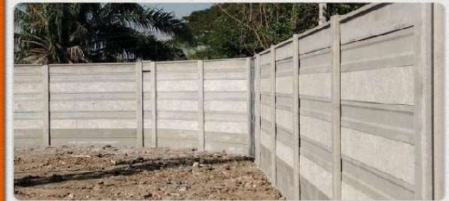
รั้วคอนกรีต
