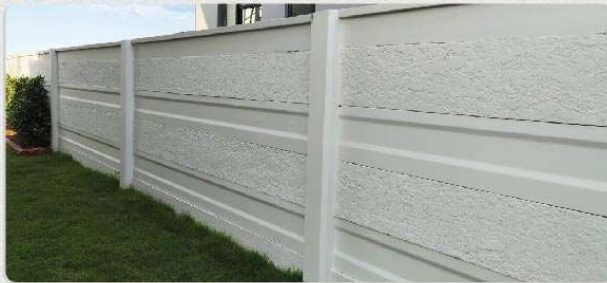
รั้วคอนกรีต
