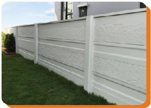
► ติดตั้งรั้วคอนกรีตสำเร็จรูป
