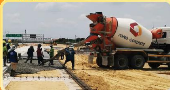
คอนกรีตผสมเสร็จ
