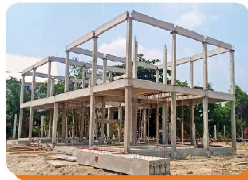
► ติดตั้งโครงสร้างคาน-เสาสำเร็จรูป
