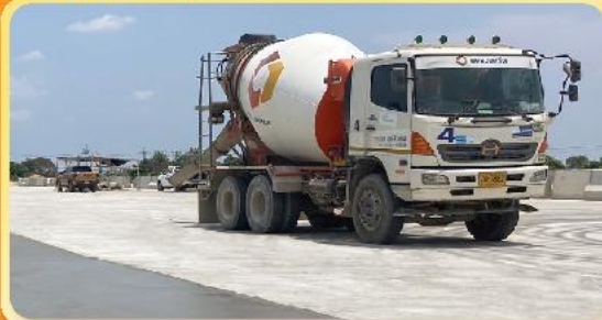
คอนกรีตผสมเสร็จ
