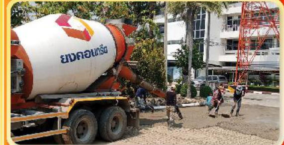
คอนกรีตผสมเสร็จ
