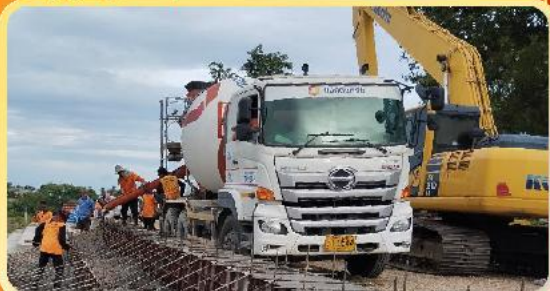
คอนกรีตผสมเสร็จ
