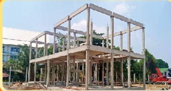
โครงสร้างคานเสา
