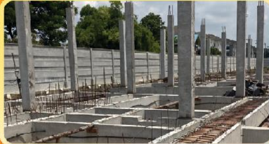
โครงสร้างคานเสา
