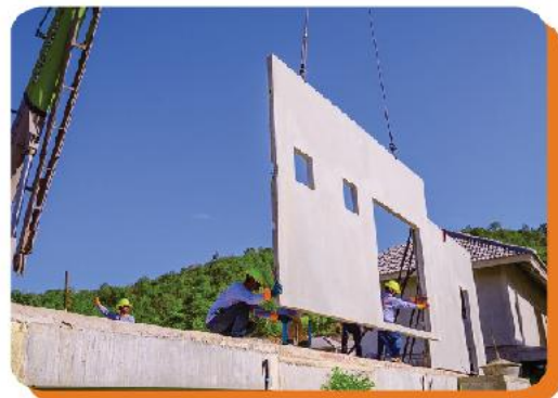
► ติดตั้งผนังสำเร็จรูป
