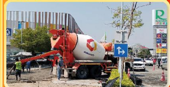
คอนกรีตผสมเสร็จ
