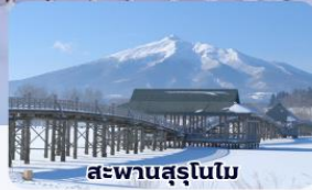
สะพานสุรุโนโม
